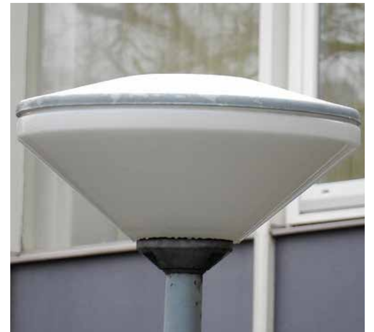
Conische mast met Friso Kramer armatuur Hoogte: 4 meter Toepassing: standaard mast, 30km straten, voetgangersgebieden
