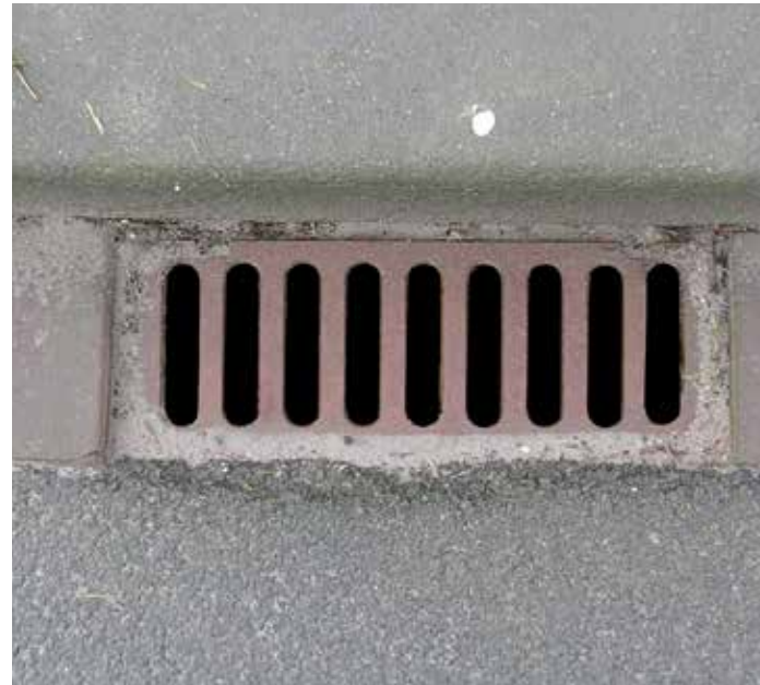
Straatkolk ODS in rollaag 20x20 betontegel rood
