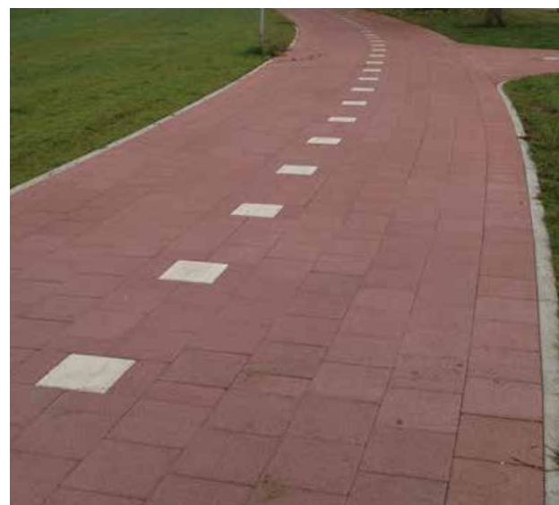
Betontegel rood, 30x30 cm Tijdelijke toepassing, in latere fase wordt in Strawinsky asfalt toegepast.
